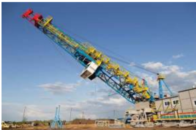
Рис. 25. Подъем собранной мачтовой вышки [red-met.ru]
